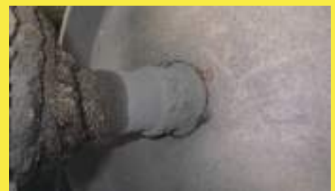
▲ 溶接部の欠陥はプーリが折損する大きな要因に
