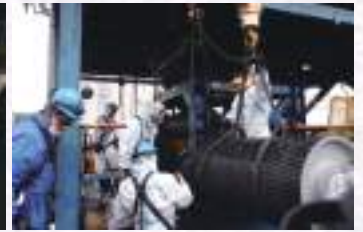
▲ ドライブプーリ交換工事
