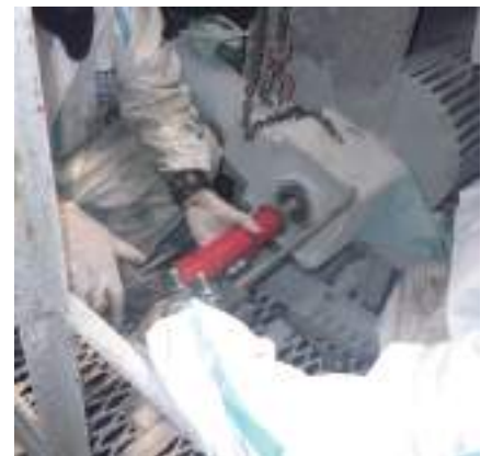
▲ 軸上減速機交換の様子
