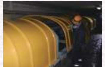
▲ コンベヤカバー (FRP 製) 取付の様子
