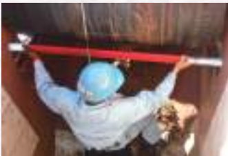
▲ アスゴ・スカルパー取付の様子
