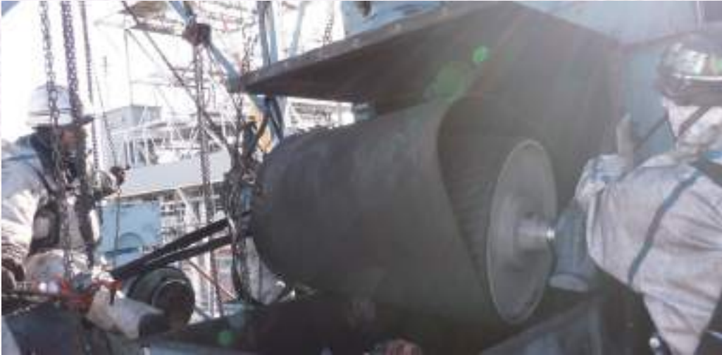
▲ ドライブプーリの交換工事
