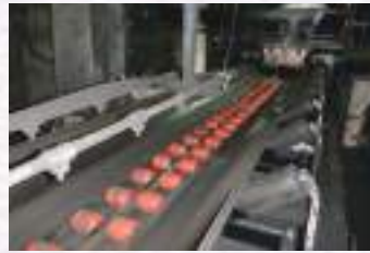
▲ コンベヤスケール点検
